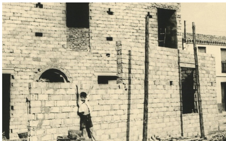
Foto 35: Construcción de viviendas
