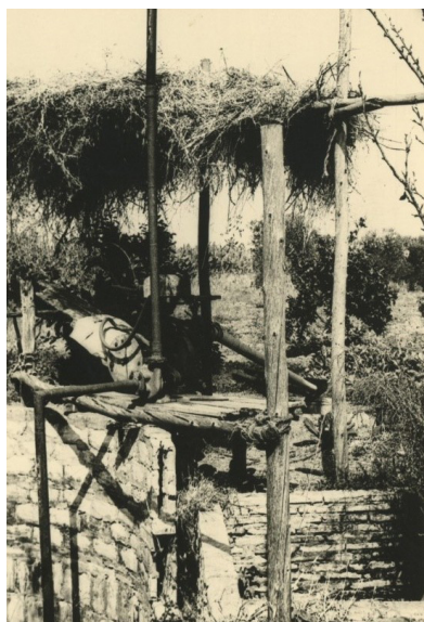
Foto 22: Cercado de Juanito. Motor del pozo para riego
