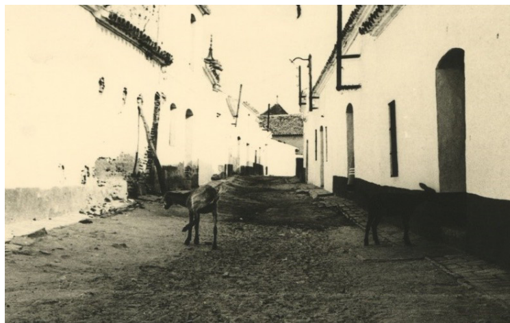
Foto 33: Calle de Villamanrique
