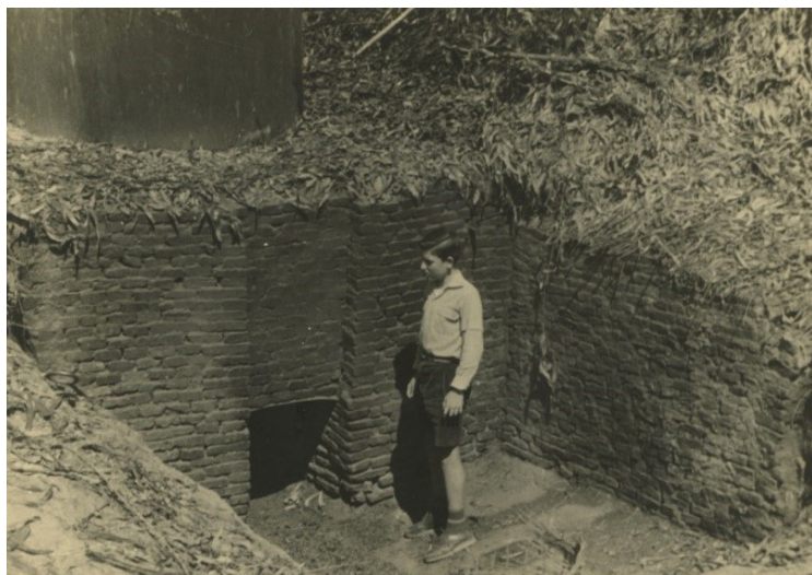
Foto 28: Horno para obtener esencias de eucaliptos
