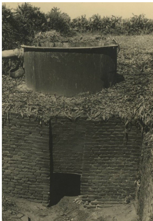
Foto 28: Horno para obtener esencias de eucaliptos
