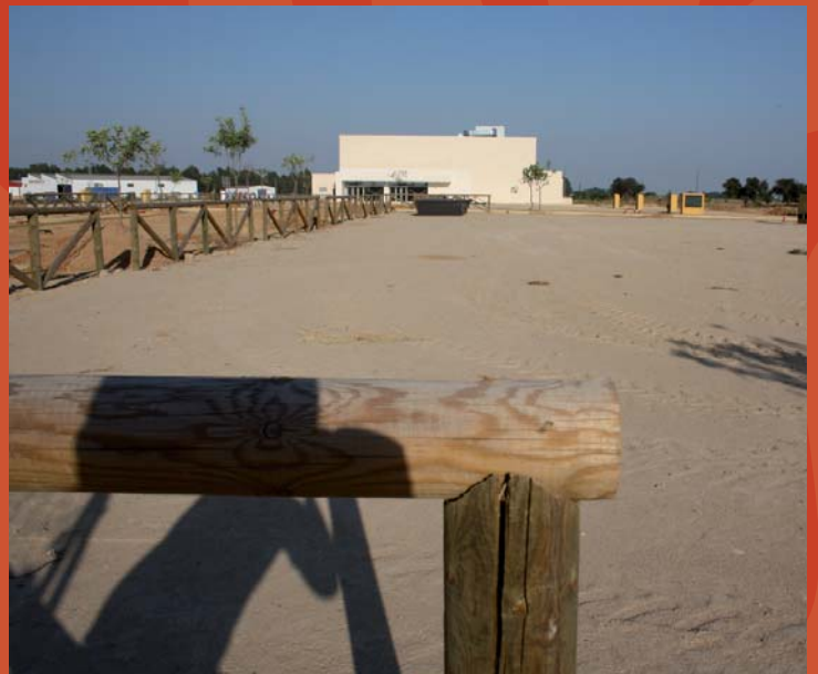
Imagen actual de la feria con las obras de adecuación del recinto
